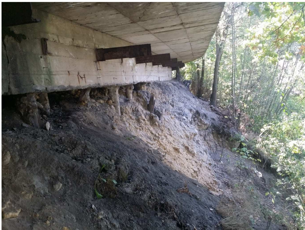
Obr. 1.: Odlučná oblasť zosuvu a obnažené mikropiloty železobetónovej mostovky
